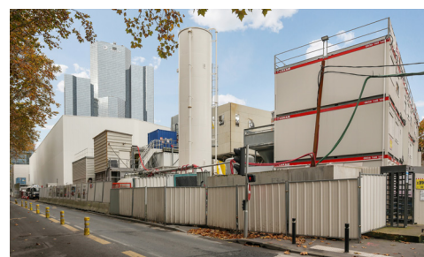
Bureaux de la base vie du puits au tunnelier - Direction du Projet Eole SNCF Réseau
