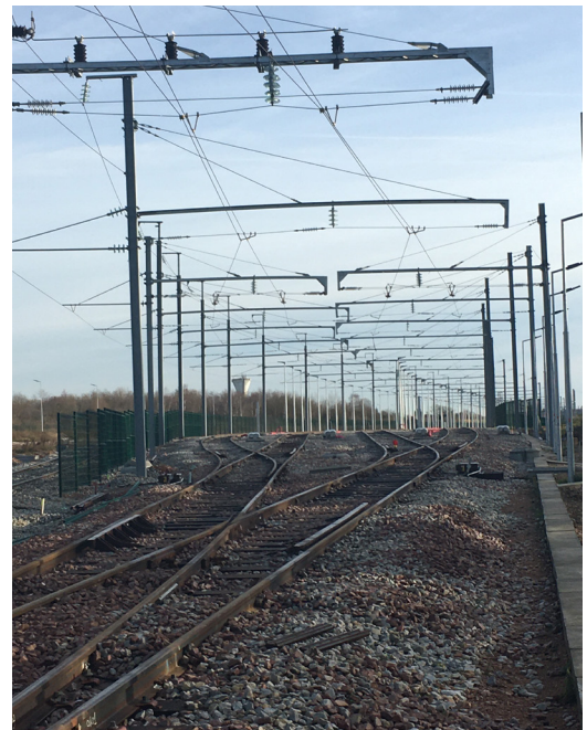
Credit photo Direction du projet Eole - Garage d'Issou Gargenville
