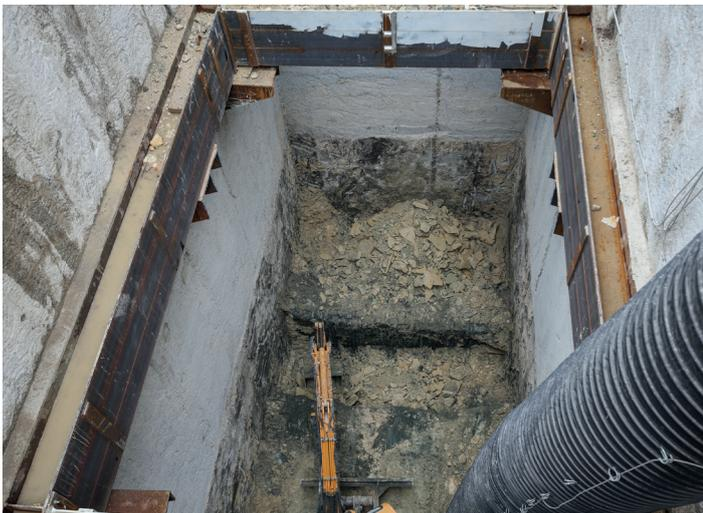
Cette phase travaux, consiste à creuser l'intérieur du Puits, sur une profondeur de 35 mètres. En fonction des couches géologiques rencontrées, comme le calcaire (roche dure), l'excavation pourra être bruyante. De ce fait, des bâches acoustiques supplémentaires ont été ajoutées et un brumisateuse mis en place pour atténuer les poussières.
