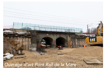
Ouvrage d'art Pont Rail de la Mare
