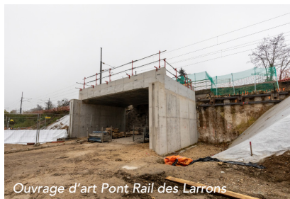
Ouvrage d'art Pont Rail des Larrons
