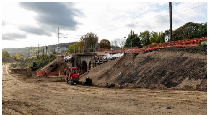
Travaux de soutènement le long de la voie existante
