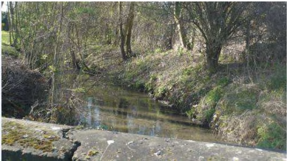
Figure 68 : Photographie du fossé passant à proximité du point C - Source : SAFEGE
