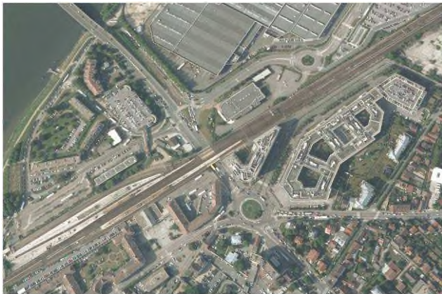
Figure 34 : Photo aérienne de la gare de Poissy - source : GoogleEarth
