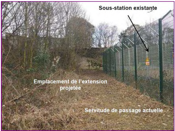
Figure 11 : Photo du site de la sous station de Noisy - source : SNCF, 2013
