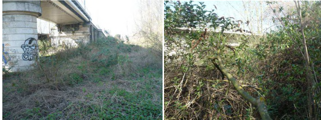
Figure 81 : Photographies au droit des points C et E - Source : SAFEGE
