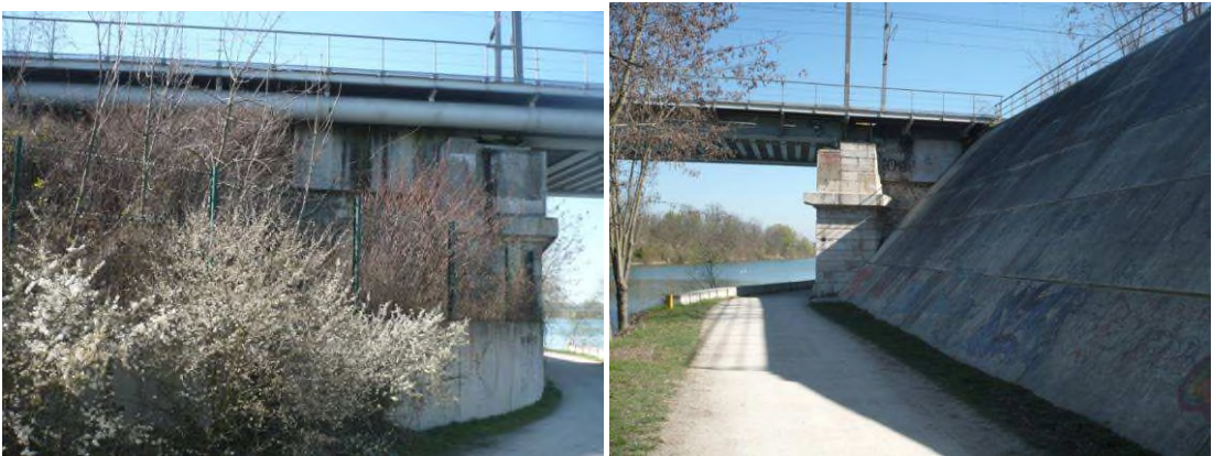
Figure 78 : Photographies au droit du point A - Source : SAFEGE
