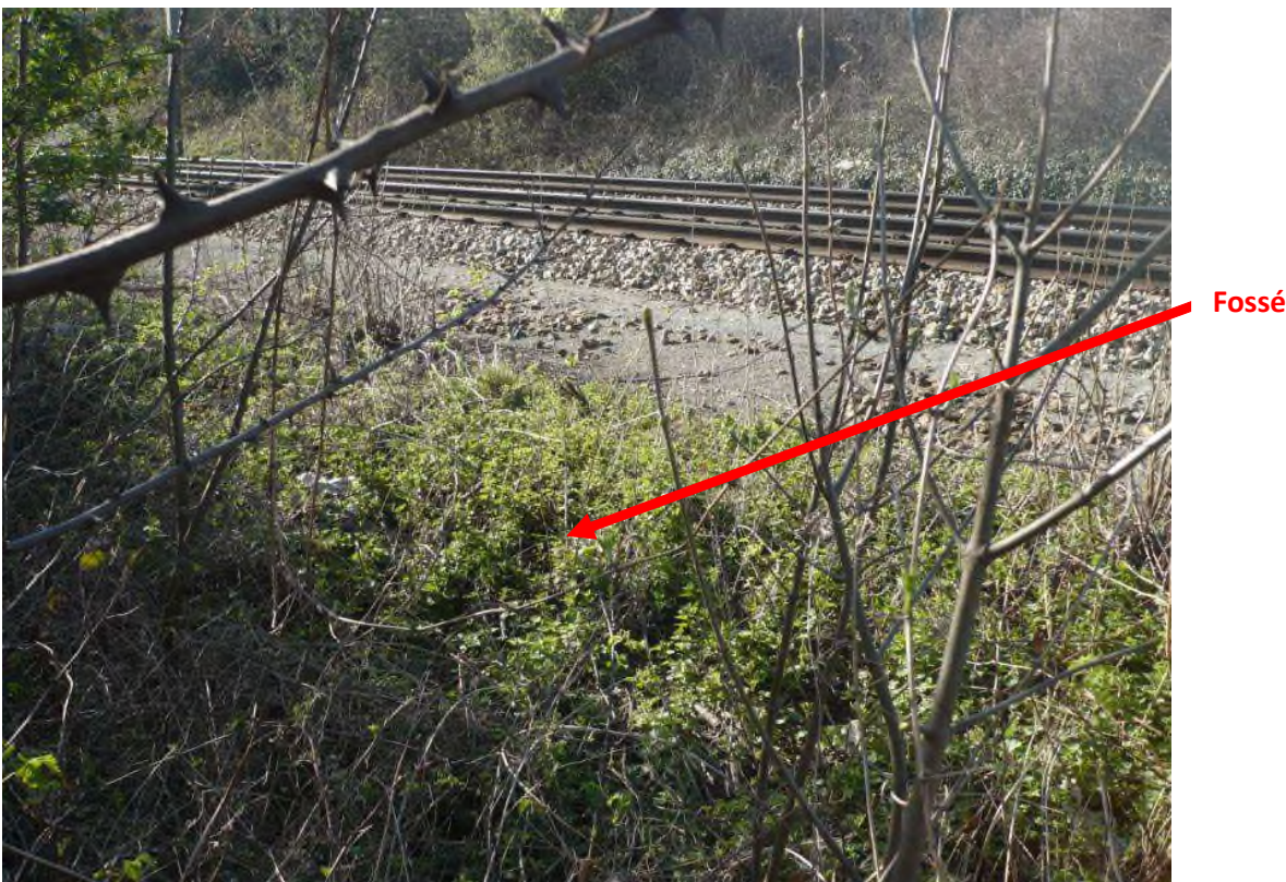
Figure 66 : Photographie au droit du point B - Source : SAFEGE
