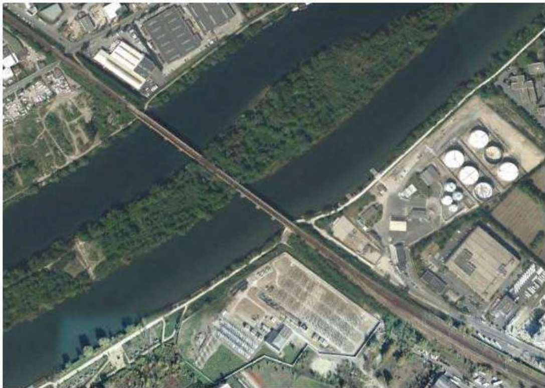
Figure 30 : Photo aérienne du franchissement entre Bezons et Nanterre - source : GoogleEarth
