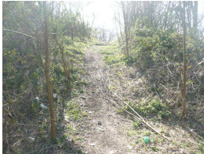
Figure 89 : Photographie au droit du point K - Source : SAFEGE
