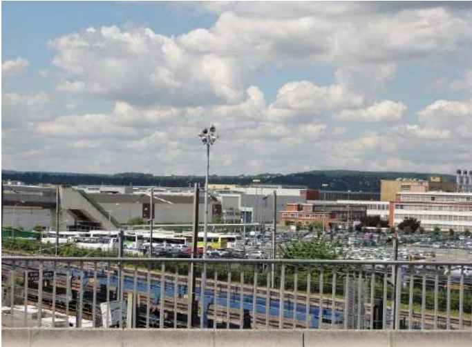
Photographie 160 : Vue depuis le pont-route de la D30 vers le site de l'usine Peugeot (DSC01760)
