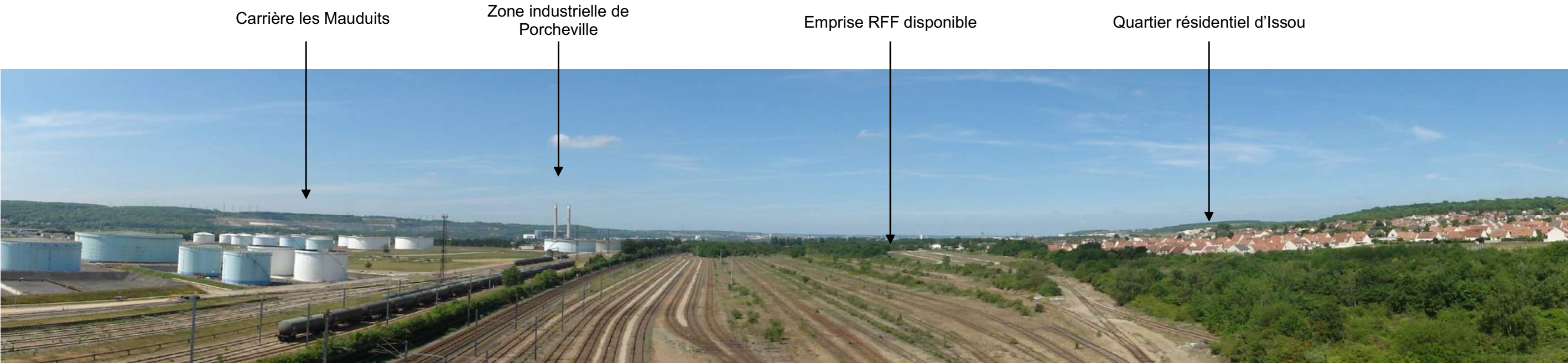
Photographie 197 : Ensemble du périmètre de la gare de Gargenville (DSC01201)
