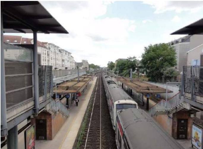
Photographie 157 : Voies en déblai au niveau de la gare de Maisons Laffitte (DSC01774)
