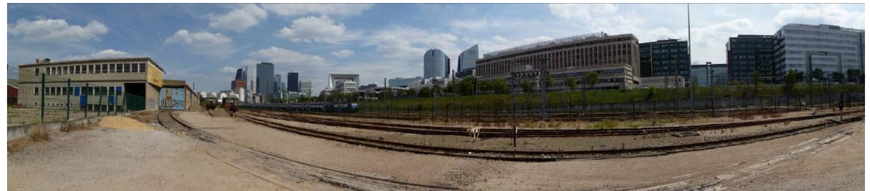
Photographie 149 : (P1040396) – Rapport de plein et de vide entre les quartiers de bureaux et l'emprise ferroviaire
