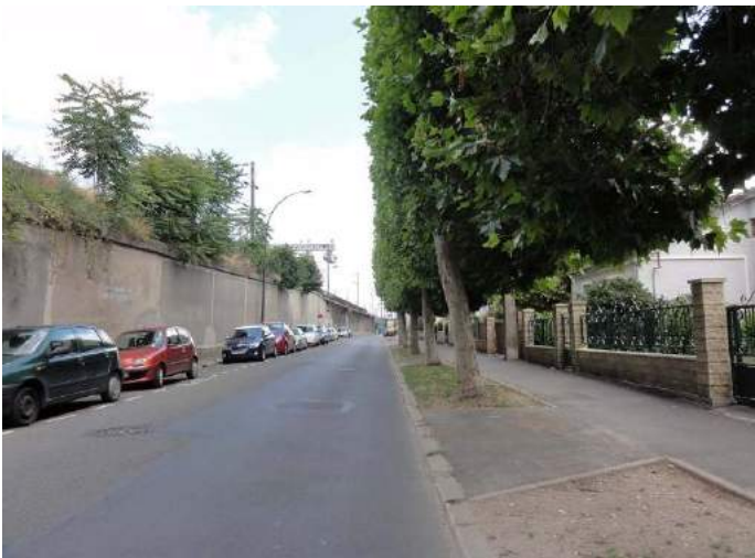
Photographie 153 : Emprise contrainte ayant nécessité de réaliser un mur de soutènement (DSC01798)
