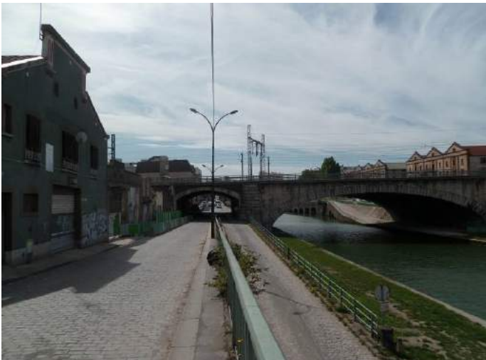
Photographie 145 : Pont rail enjambant le canal Saint Martin (P1040734)
