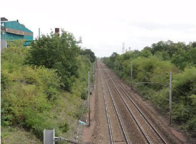
Photographie 191 : Vue sur l'usine de Limay à proximité de la voie (DSC01854)
