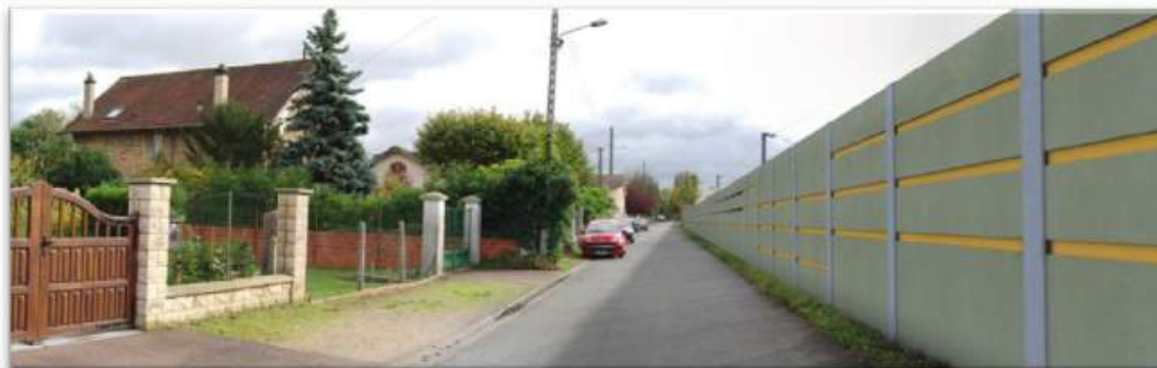
Après mise en place d'un écran acoustique
