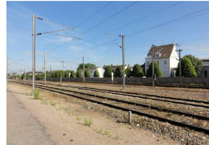
Photographie 186 : Habitat voisin de l'emprise d'implantation du futur bâtiment d'entretien (DSC01165)
