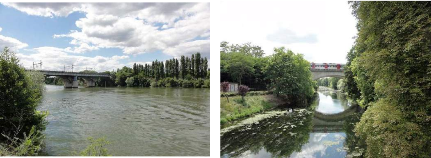
Photographie 156 : Vue depuis Sartrouville sur l'ouvrage ferroviaire enjambant la Seine (DSC01793)
