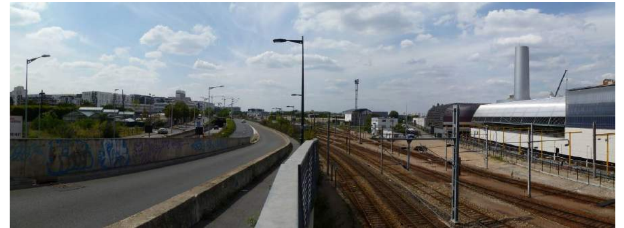
Photographie 150 : (P1040363) – Cohabitation des infrastructures de transport
