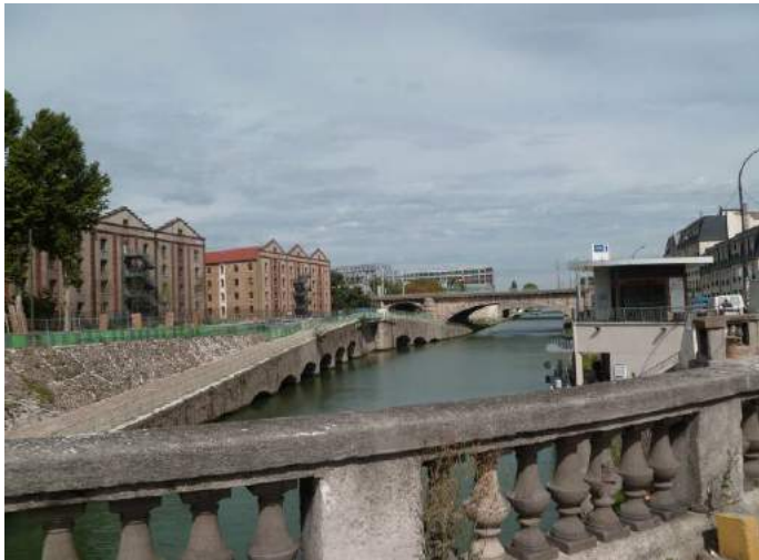
Photographie 143 : Pont rail enjambant le canal Saint Martin (P1040748)
