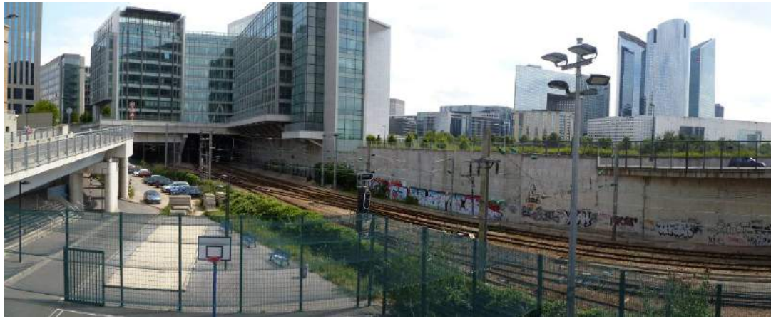
Photographie 146 : (P1040359) – Débouché du tunnel ferroviaire
