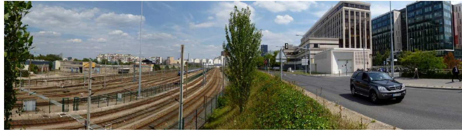
Photographie 151 : (P1040386) – Emplacement de la nouvelle gare Nanterre – La folie
