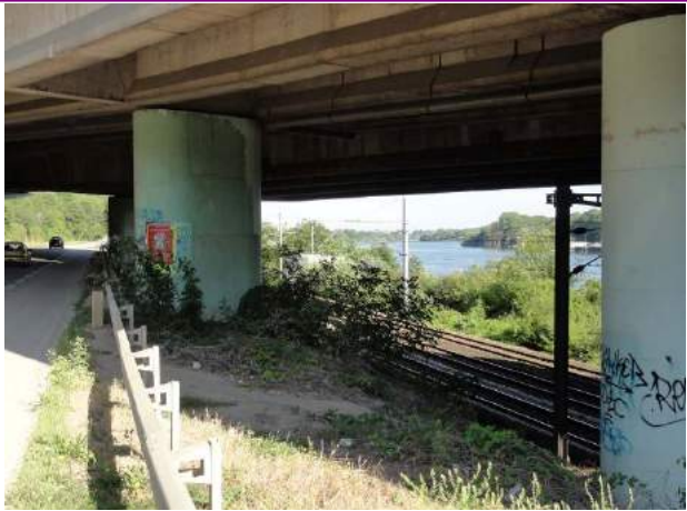
Photographie 182 : Chevauchement de la ligne par l'autoroute A13 (DSC01655)
