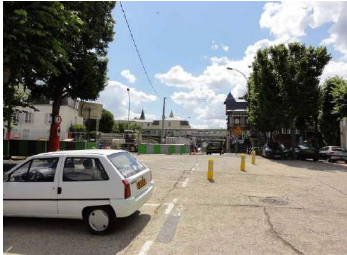
Photographie 163 : Perspective sur un pont-rail au sein du tissu urbain (DSC01744)
