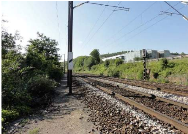
Photographie 183 : Vue depuis la voie sur les bâtiments industriels en entrée de Mantes la jolie
