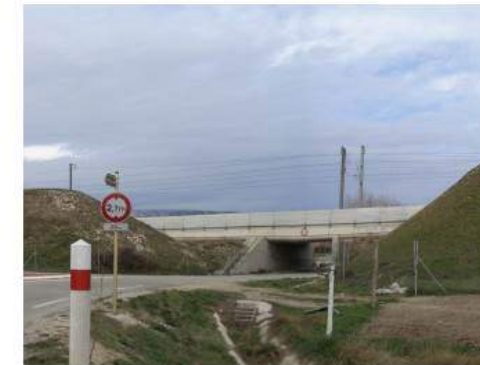
Merlon acoustique à proximité d'un passage inférieur
