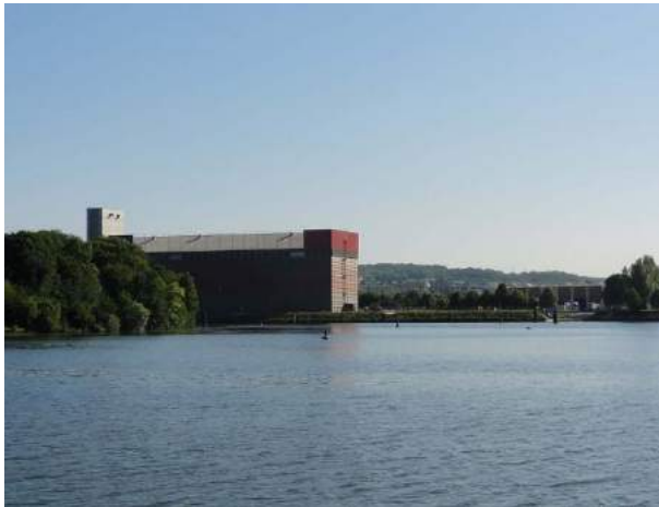
Photographie 184 : Vue depuis la berge sur le port de Limav (DSC01638)
