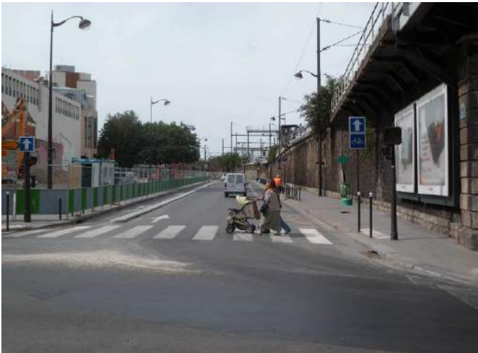
Photographie 144 : Murs de soutènement en meulière (P1040760)
