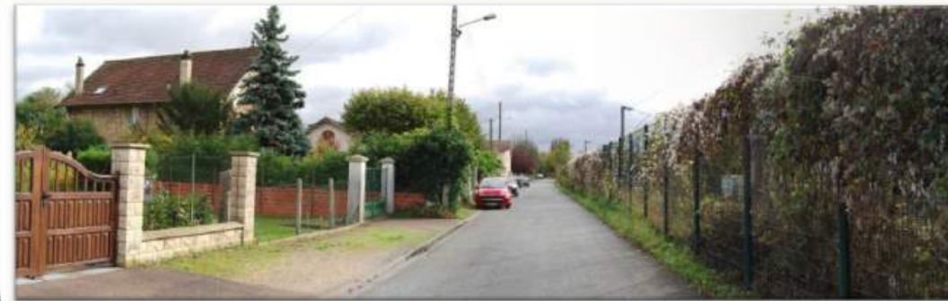
Avant mise en place d'un écran acoustique
