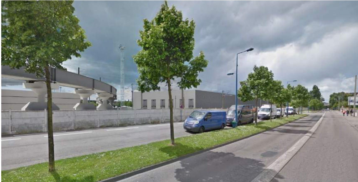
Vue depuis la rue Pierre Sépard avec l'atelier principal en second-plan
