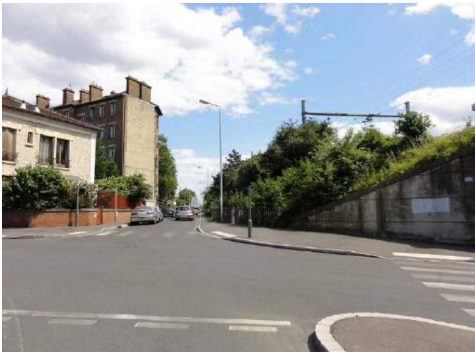
Photographie 154 : Voies en déblai au carrefour des rues Voltaire et de la Convention (DSC01825)
