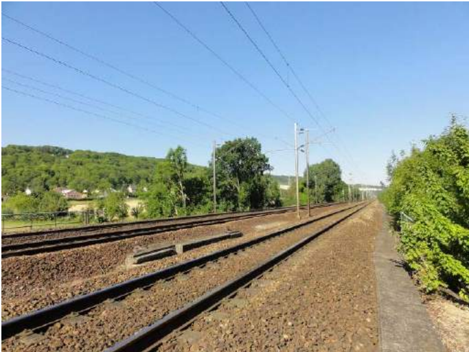
Photographie 175 : Plateforme ferroviaire remblai accompagnée de talus plantés dans la plaine agricole (DSC01681)
