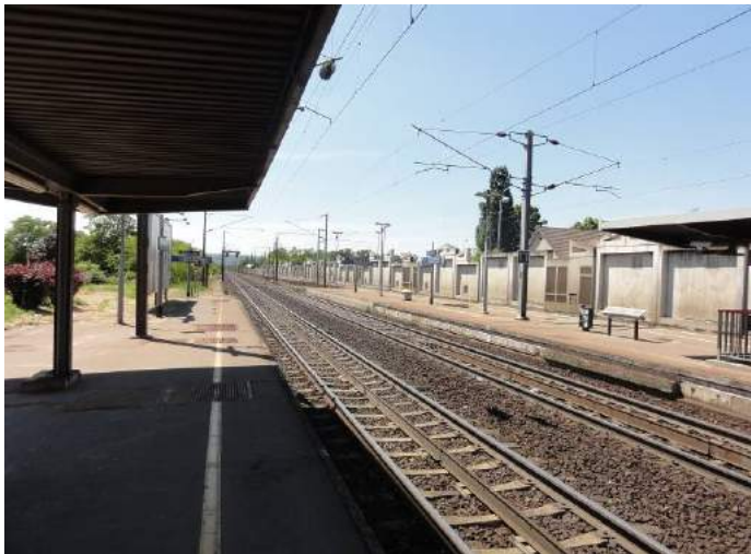
Photographie 171 : Vue depuis les quais de la gare d'Elisabethville vers Mantes (DSC01215)
