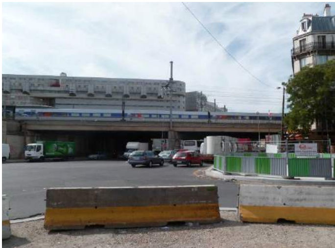
Photographie 142 : Pont Rail enjambant l'avenue de la porte de la Villette (P1040726)
