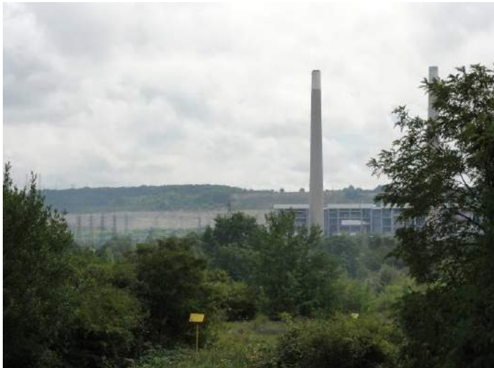
Photographie 196 : Vue depuis Limay sur la centrale de Porcheville (DSC01853)
