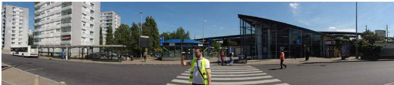
Photographie 169 : Vue panoramique sur le parvis de la gare des Mureaux (DSC01219)
