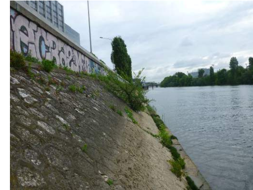
Figure 55 : Vue de la berge au droit du port fluvial - source : Hydrosphère 2014
