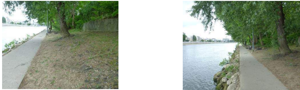
Figure 116 : Berges de l'île de la Jatte à Neuilly (source : Hydrosphère)
